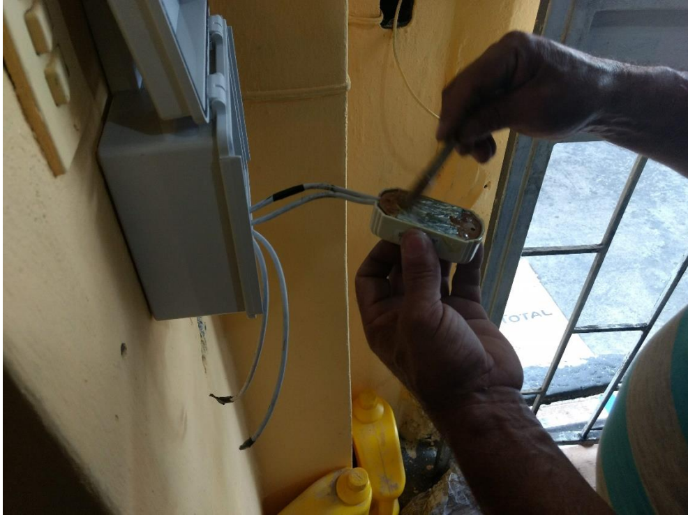
Figura 54 - Instalación de la base para el biométrico
