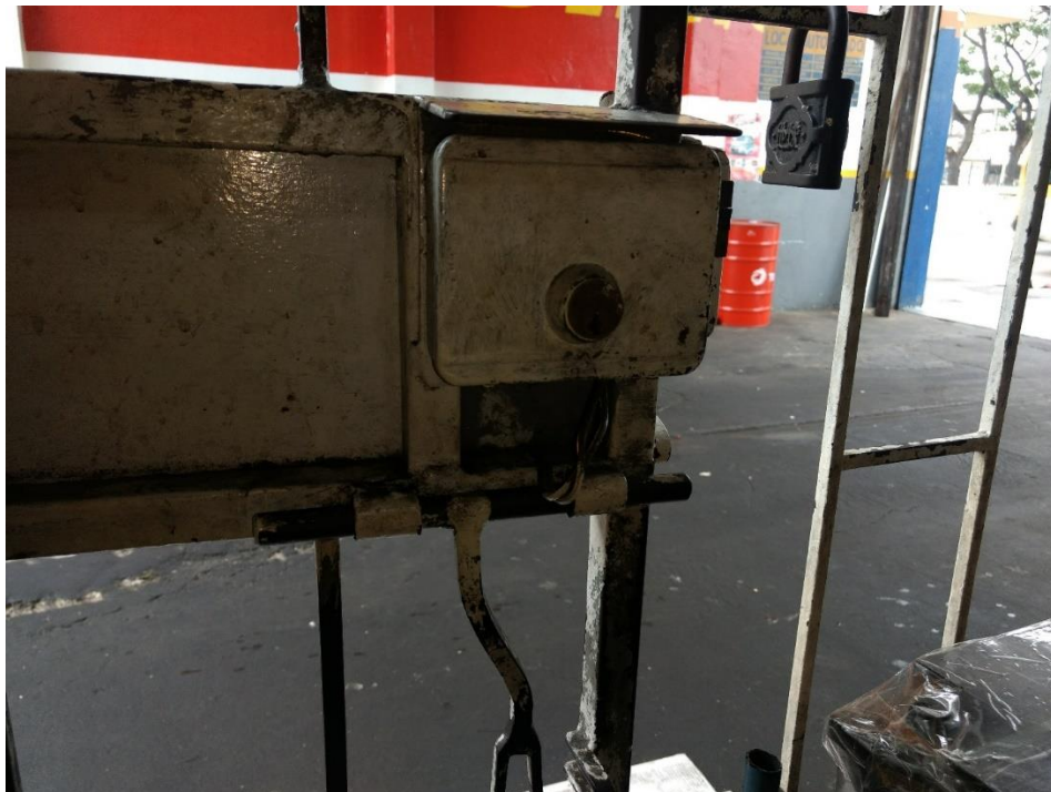
Figura 55 - Chapa eléctrica para control de apertura
