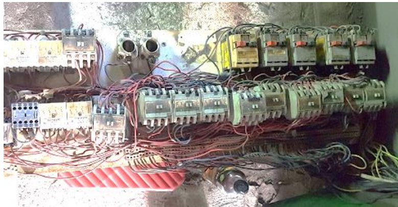
Figura 3.10 Desmontaje del tablero principal
