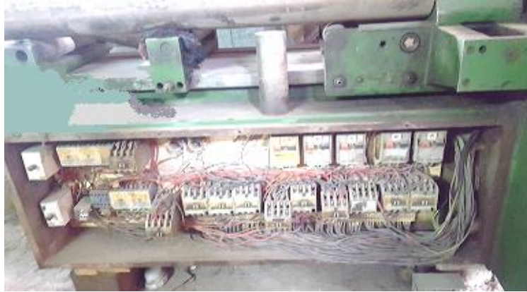
Figura 3.9 Tablero previo a la automatización
