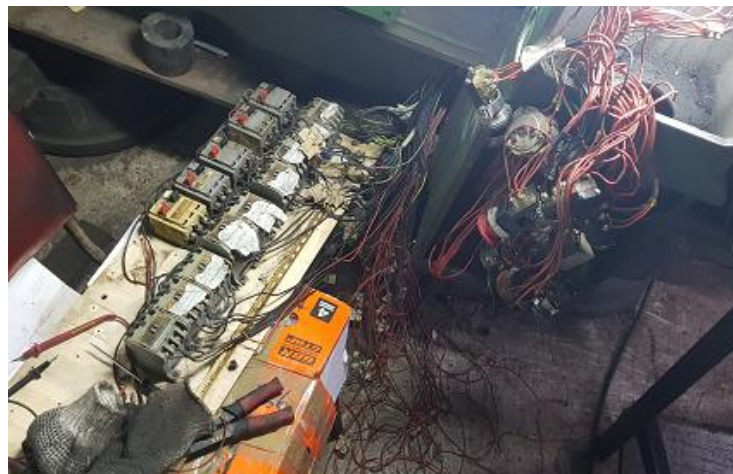
Desmontaje de elementos electromecánicos innecesarios para la automatización. Elaborado por: Christian Proaño
