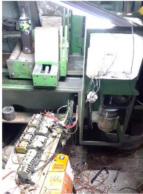
Figura 3.13 Desmontaje de interruptores y botones de la unidad de mando
