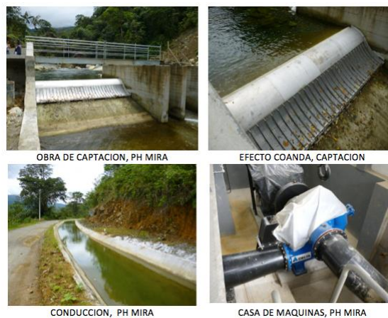
Figura 2. Proyecto hidroeléctrico Mira [4].
