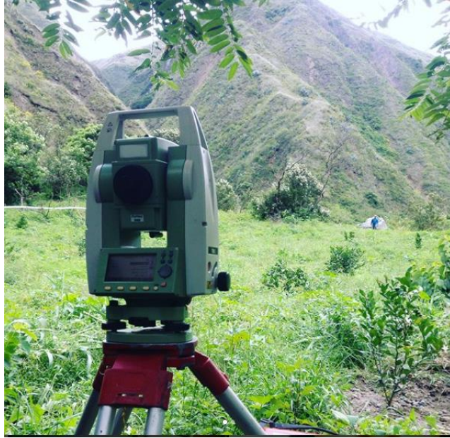
Anexo 3. Levantamiento topográfico en el sitio Fuente: Hugo Macas y Stalin Maza
