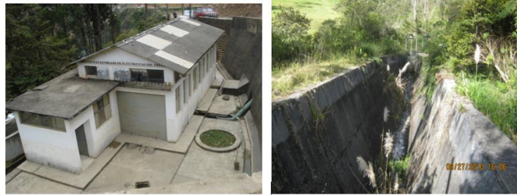
Figura 3. Partes del proyecto hidroeléctrico Gualaceo [4].
