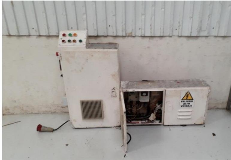
Figura 57. Desmontaje de Tablero antiguo
