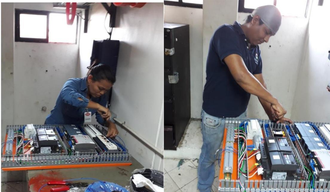
Figura 89. Instalación de Partes y piezas módulo de control nuevo
