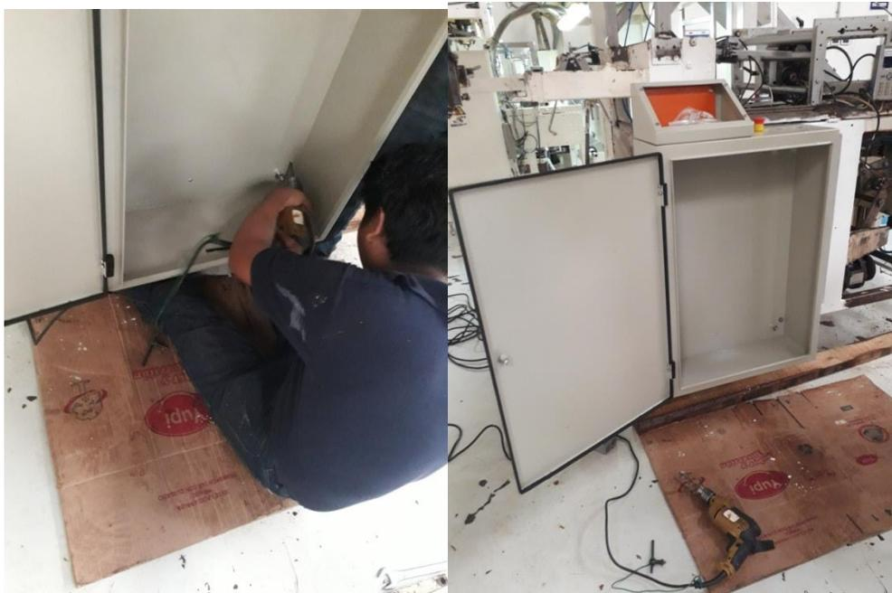
Figura 91. Montaje de tablero de control nuevo
