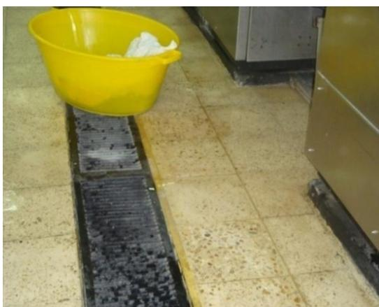
Figura 9. Presencia de agua junto a las lavadoras
