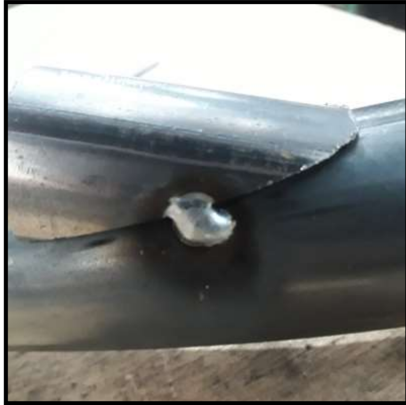
Figura 6.137 Punto de soldadura
