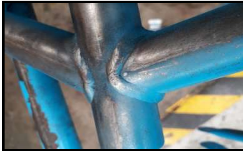
Figura 6.142 Cordón final de soldadura
