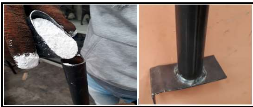
Figura 6.124 Llenado de los tubos con arena sílice
