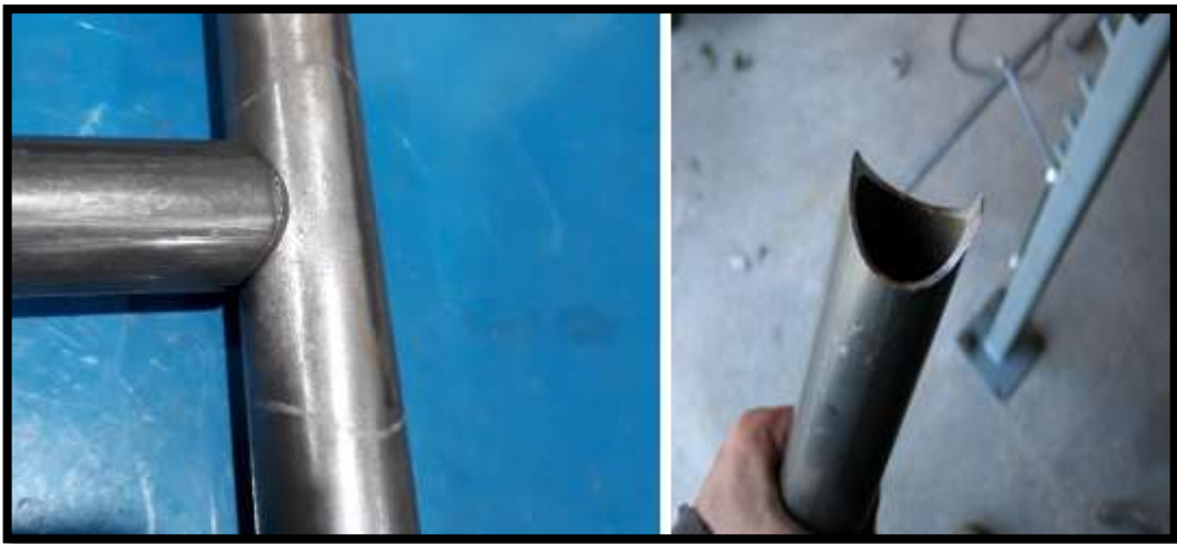
Figura 6.132 (a) Esmeril; (b) Union de tubos tipo boca de pescado
