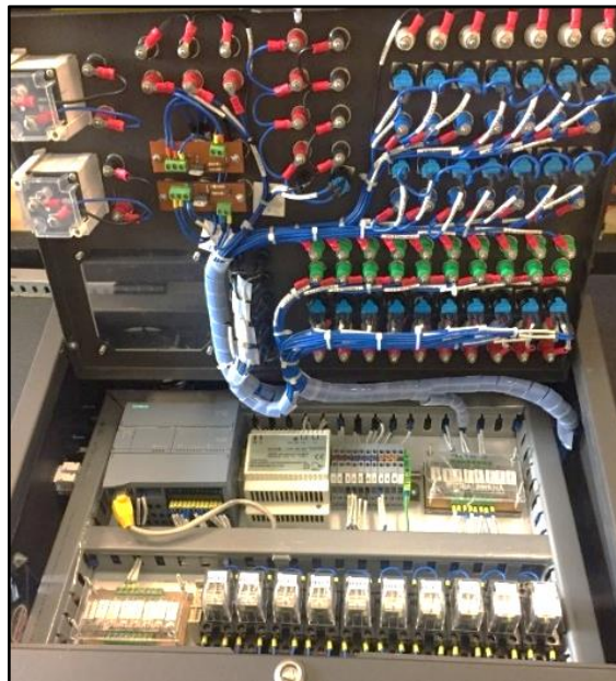
FIGURA 57: CABLEADO INTERNO DEL MALETÍN DIDÁCTICO [AUTORES]
