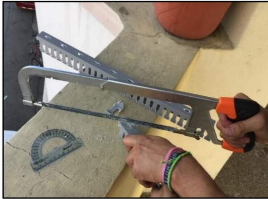
FIGURA 39: CORTE A 45 ° EN LOS EXTREMOS DE LAS CANALETAS [AUTORES]
