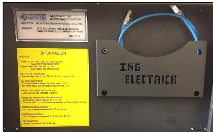
FIGURA 59: COLOCACIÓN DE CUADROS DE INFORMACIÓN Y PORTA CABLES [AUTORES]
