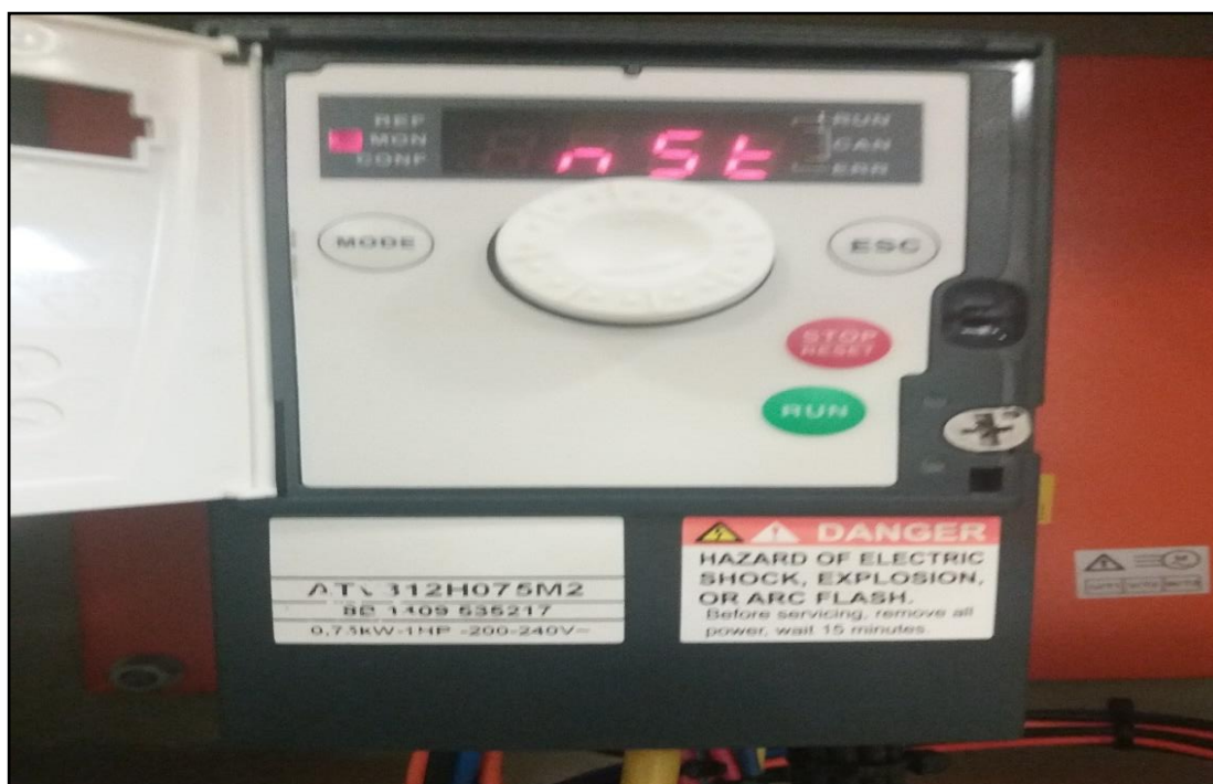
FIGURA 82: VARIADOR EN ESTADO NST [AUTORES]
