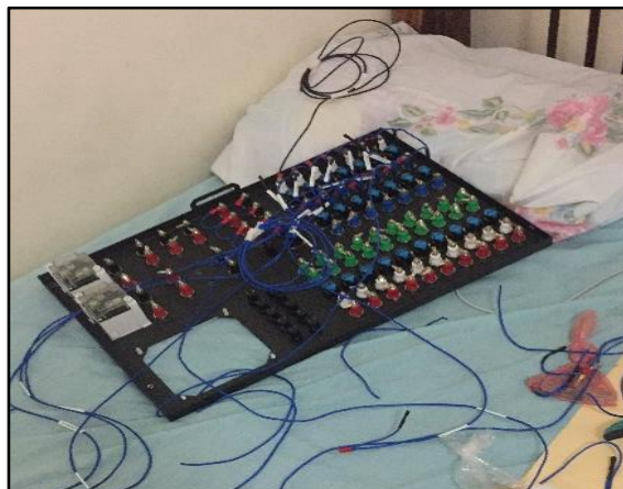
FIGURA 53: CABLEADO DE LA TAPA MOVIL DE CONEXIÓN [AUTORES]
