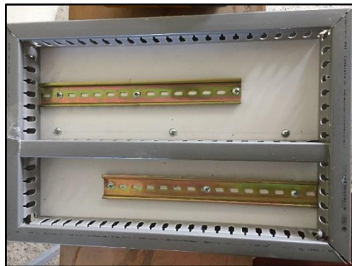
FIGURA 42 : COLOCACIÓN DEL RIEL DIN [AUTORES]
