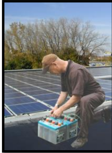
Figura 76: Problema de baterías.
