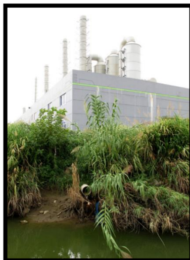
Figura 74: Drenaje ácido de una planta operada por Solar Holding Co.
