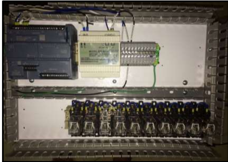
FIGURA 37: UBICACIÓN DE EQUIPOS EN EL PLAFÓN.
