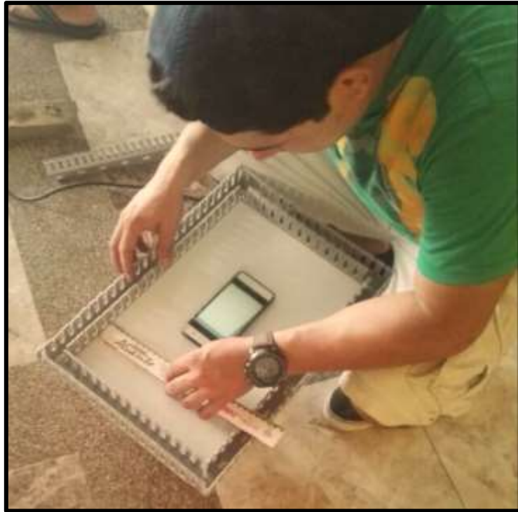
FIGURA 35: COLOCACIÓN DE CANALETA EN EL PLAFÓN.
