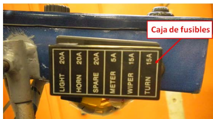
Fig. 4. 39 Caja de fusibles del tablero de control.
