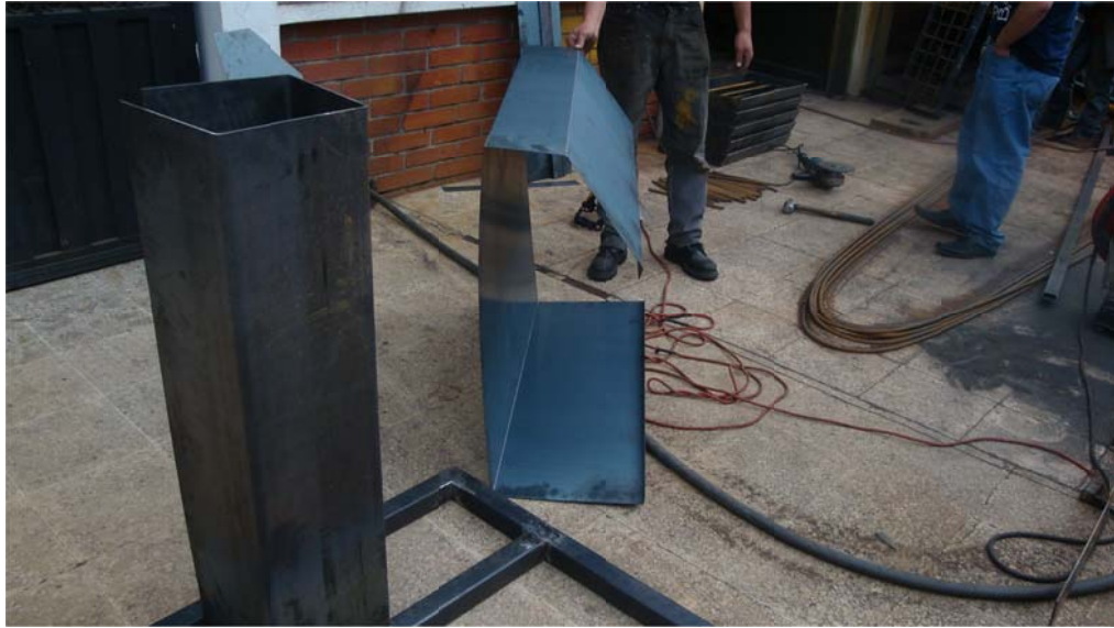
Figura 3.18 Construcción del armario
