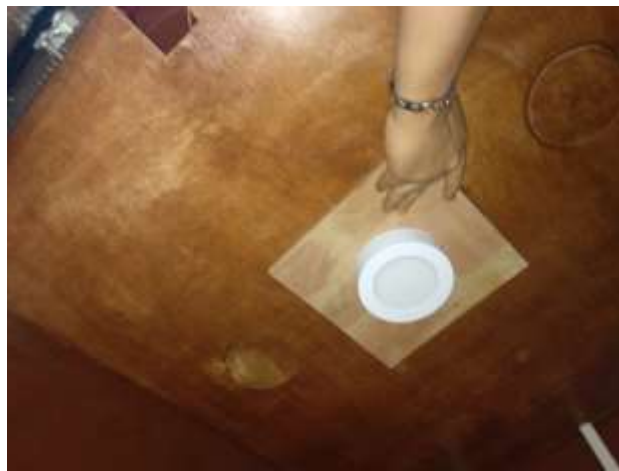
Figura 181 Luminaria de L1 apagada
