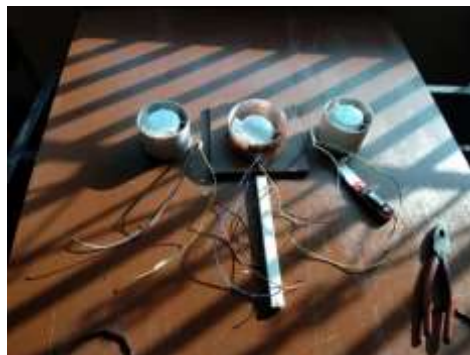
Figura 159 Conexión y pruebas de extractores del sistema de ventilación
