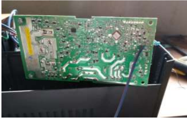
Figura 155 UPS con cables soldados directo al interruptor de encendido del UPS
