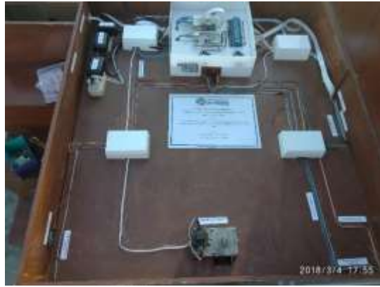
Figura 170 Cableado final del centro de control
