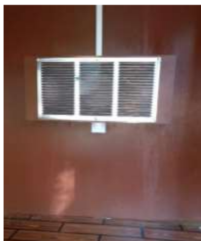
Figura 132 Extractores, caja contenedora y sensor de temperatura en zona de descanso
