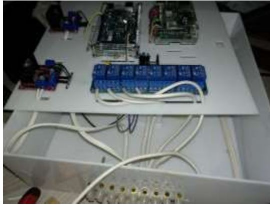
Figura 151 Conexión de relés hacia bornera
