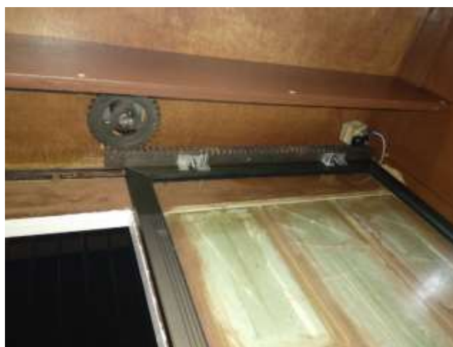
Figura 124 Engrane, cremallera, puerta y FC abre del sistema de acceso
