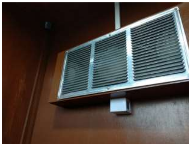
Figura 212 Extractores encendidos dentro de la zona de descanso.
