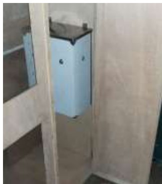
Figura 108 Ubicación del dosificador al interior de la casa
