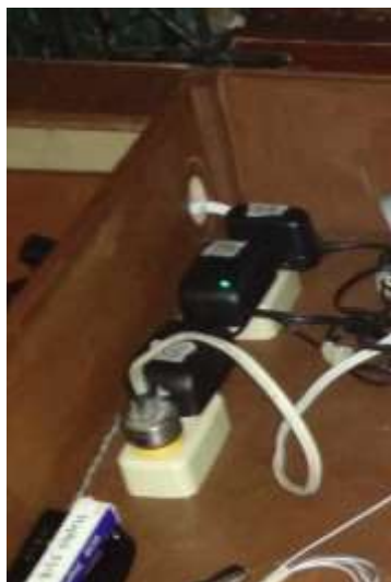
Figura 157 Tomacorrientes con protección UPS
