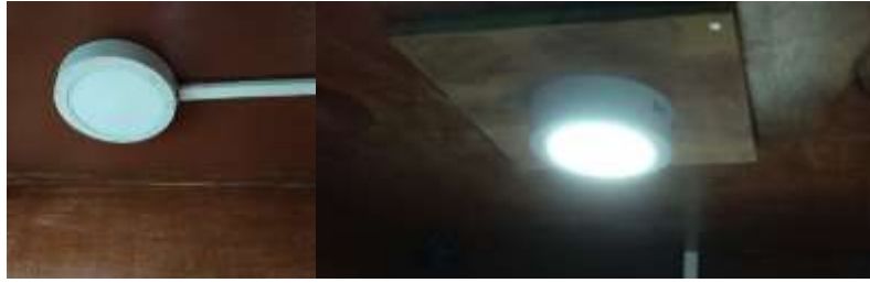
Figura 117 Luminarias instaladas en zona de alimentación y descanso
