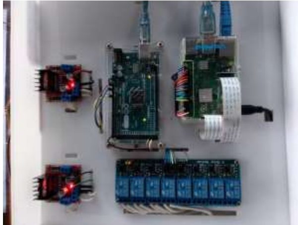
Figura 209 Estado inicial de relés del sistema de ventilación
