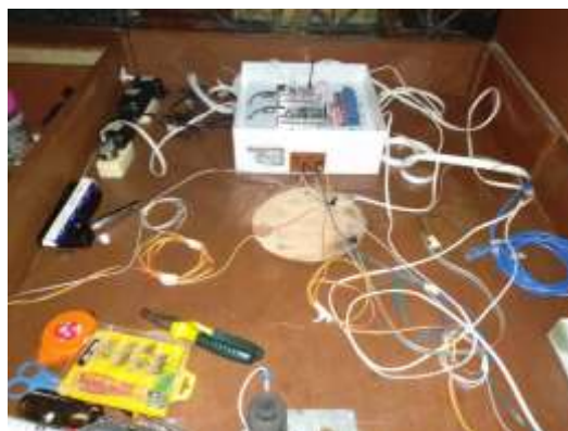
Figura 169 Integración del cableado a centro de control
