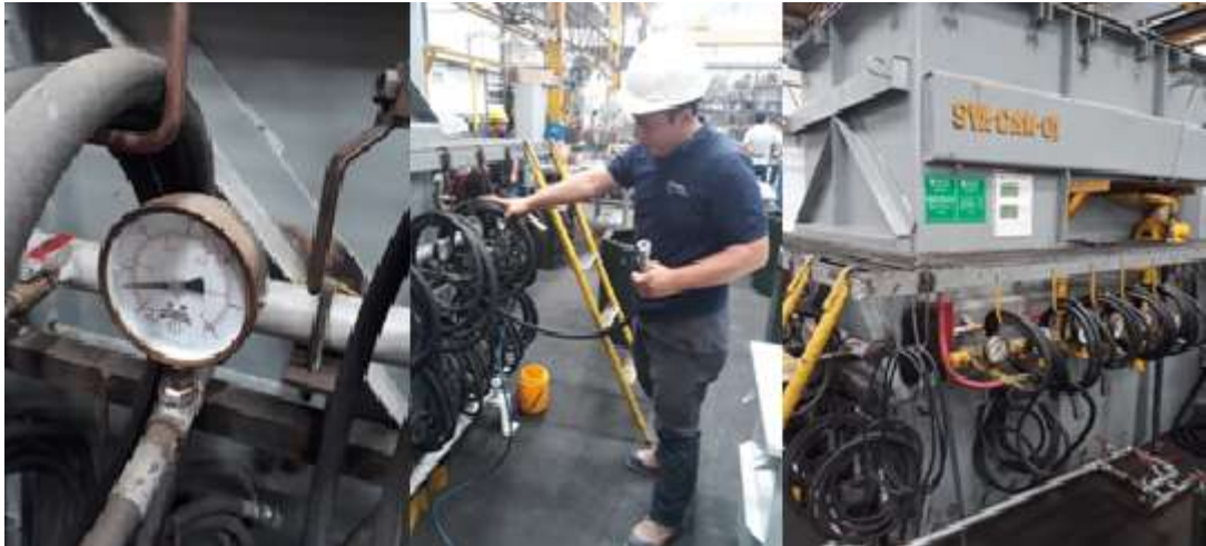
Figura 38: Proceso de encubado del transformador Fuente: Los autores
