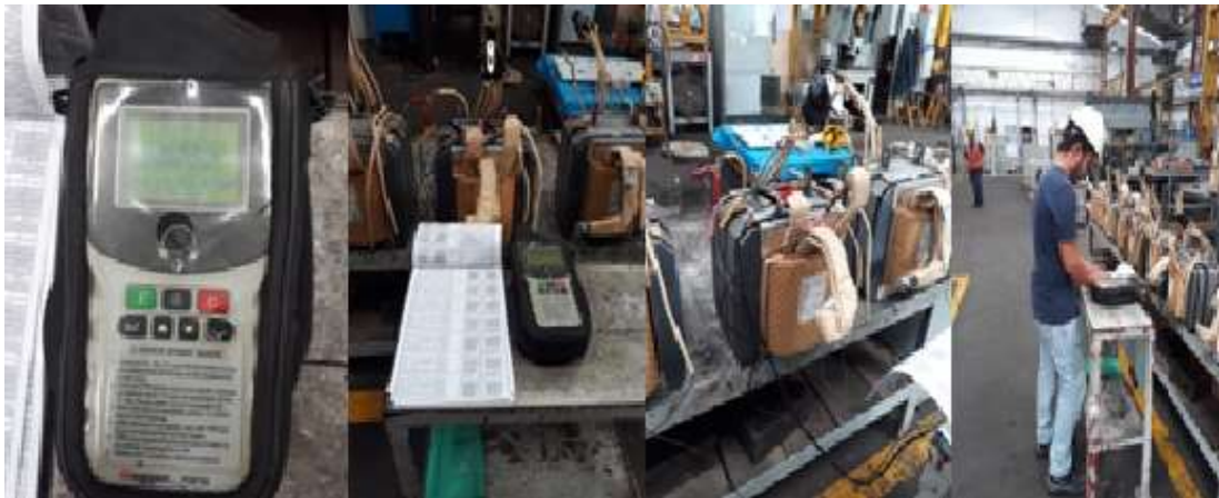
Figura 35: Prueba de relación de transformación antes de encubar la parte activa al tanque del transformador Fuente: Los autores
