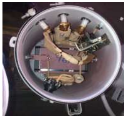
Figura 15: Parte activa del transformador en el tanque
