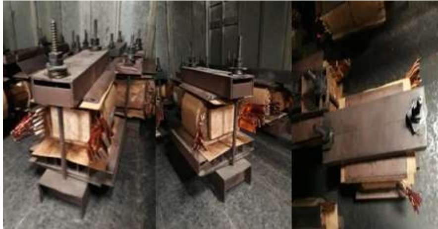
Figura 32: Proceso de prensado de las bobinas de alta y baja tensión Fuente: : Los autores
