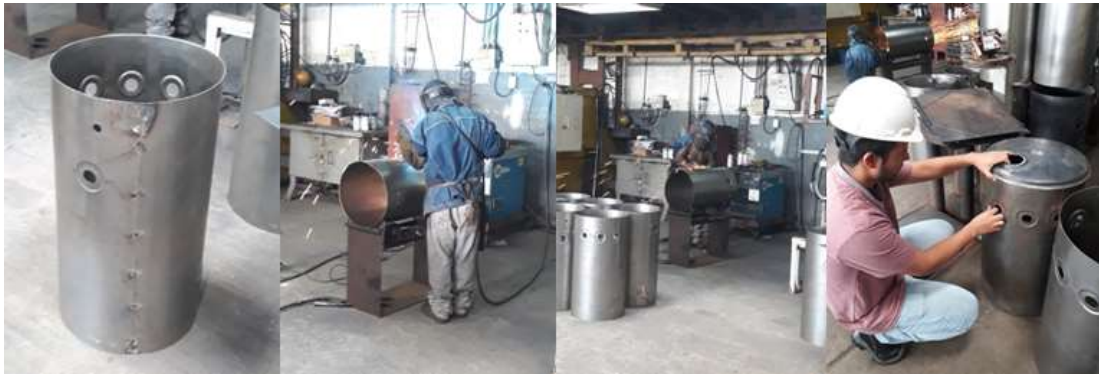
Figura 30: Soldadura y uniones de tanque de lámina de acero al carbón Fuente: : Los autores
