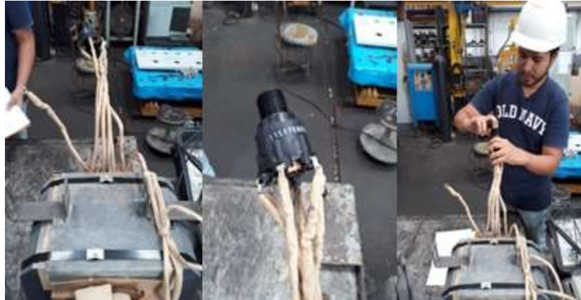
Figura 34: Prueba de conexiones y resistencia de aislamiento Fuente: Los autores
