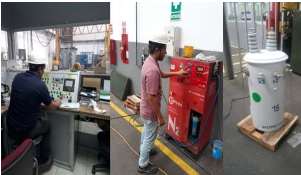
Figura 39: Pruebas eléctricas al transformador Fuente: Los autores
