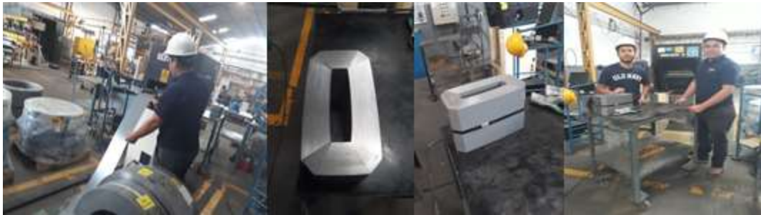
Figura 21: Proceso de corte, armado y recocido del núcleo Fuente: Los autores
