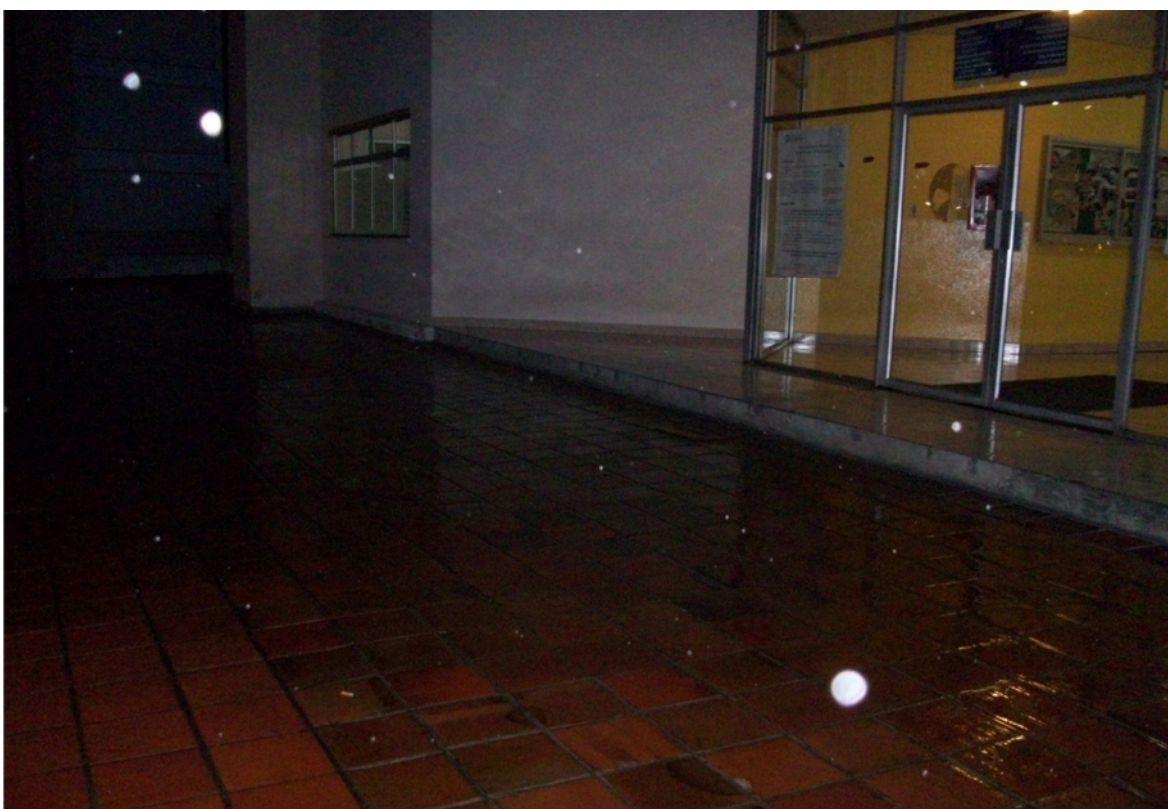
Fotografía 19 Acceso al Bloque B
