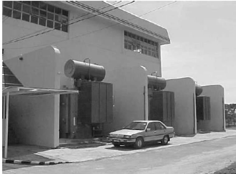
Figura 5. Subestación Interior. ( Subestaciones Eléctricas ).
