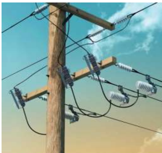
Figura 32. Seccionador fusible ubicado en red eléctrica de distribución. (Siemens, Interruptor seccionador de fusible / de tensión media / compacto / de exterior , 2017)
