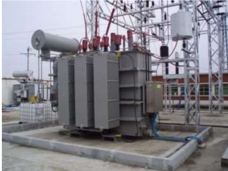
Figura 3. Subestación de Transformación. (QUE, 2010).
