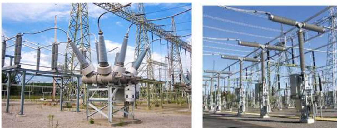
Figura 30. Interruptor de tanque muerto e Interruptor de tanque vivo. (Omicron, Aparato de prueba de impedancia / de disyuntores / de alta tensión / motorizado, 2017), (Electricidad, 2012)
