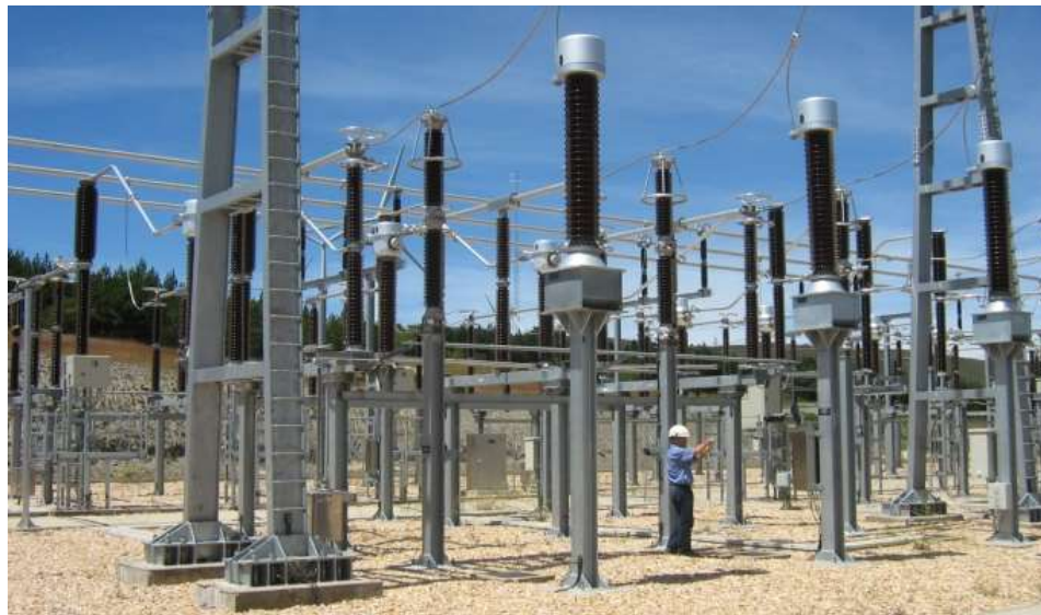
Figura 4. Subestación de Maniobras. (ASC, 2010).
