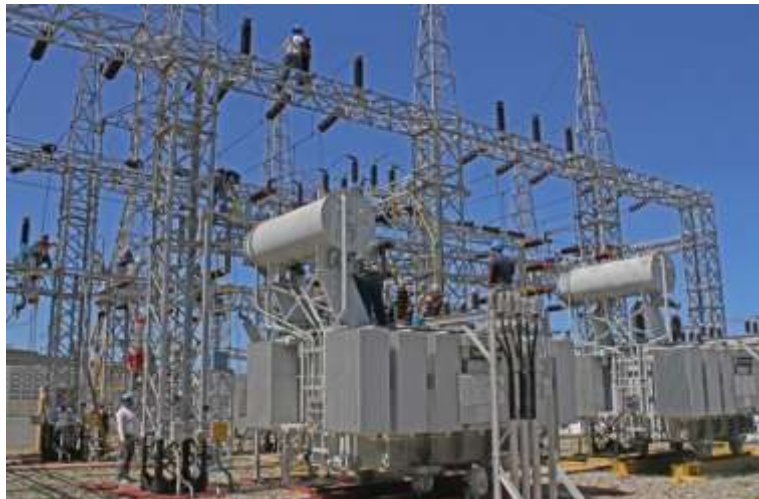
Figura 6. Subestación Intemperie. ( NotiSur, 2015 )
