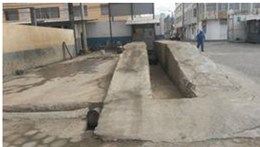
ZONA DE LAVADO DE EQUIPO CAMINERO
