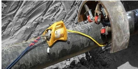
**Figura 1.1** – Radiografía en una tubería de petróleos [4].
