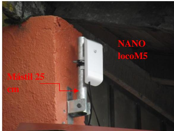
Instalación final de la antena NANO locoM5 en Aceites Esenciales, Elaborado por: López & Robalino
