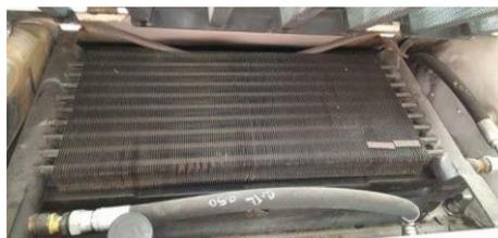
*Figura 2. Sistema de refrigeración del fluido hidráulico. Fuente: Autores.*
