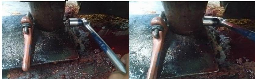
Figura 18. Forma de retirar el perno de sujeción inferior del cilindro. Fuente: Autores.
