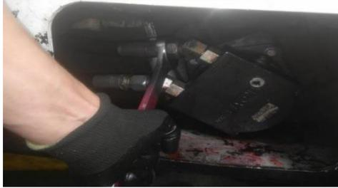
*Figura 14. Ajuste de las mangueras al motor. Fuente: Autores.*
