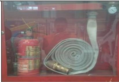
Figura 5. Elementos de control contra incendios. Fuente: Autores.
