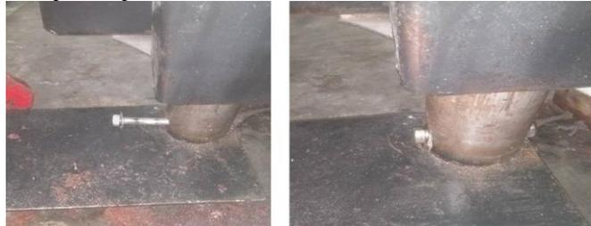
Figura 22. Colocación del perno-pasador. Fuente: Autores.
