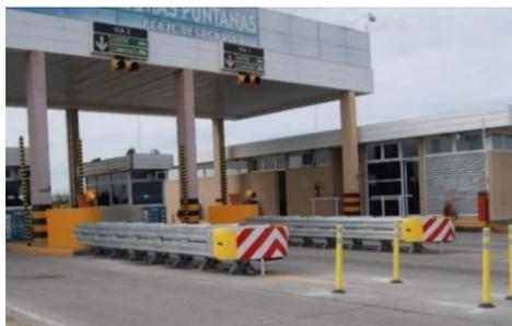
Figura 17. Terminal atenuador de impacto en caseta de peaje.
