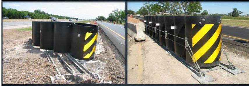
Figura 15. Terminales atenuadores de impacto en entradas y salidas de carretera.
