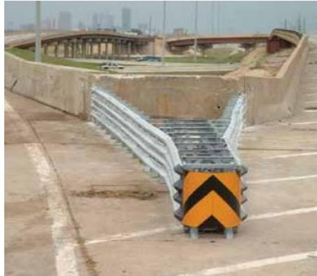
Figura 9. Sistema TRACC.
