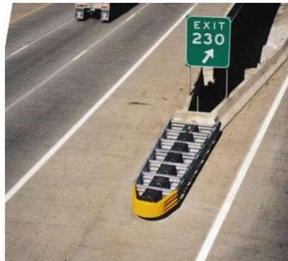
Figura 16. Terminal atenuador de impacto en bifurcación.
