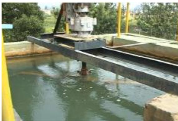
**Ilustración 9.** Sistema de floculación mecánica utilizado en una planta de tratamiento de aguas
