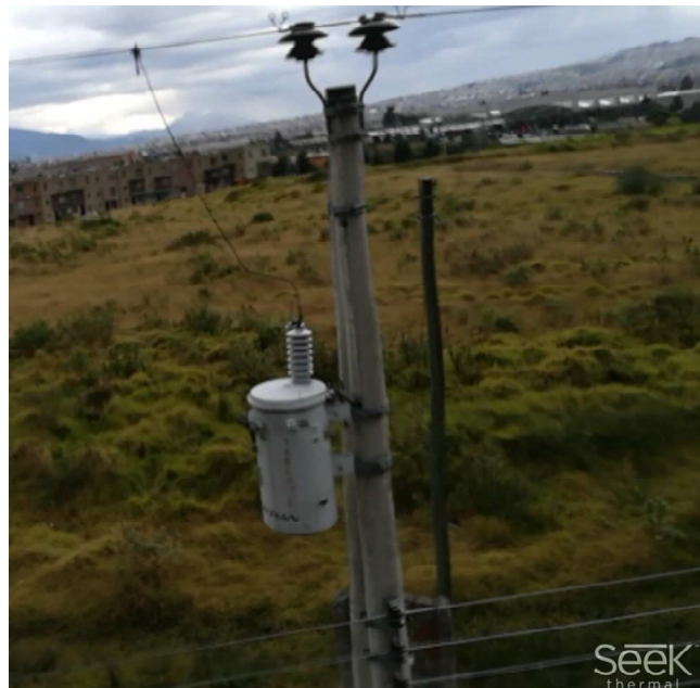
Figura 1.1 Transformador eléctrico de distribución suspendido en poste Elaborado por: Marco Ramos y Gabriel Molina
