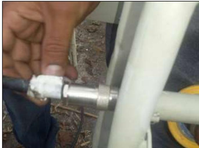
Se conecta el cable de cobre con conector tipo N en la antena,
