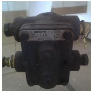
Trampa de vapor de la batidora para evacuar el vapor condensado. (Pérez & Cofre)
