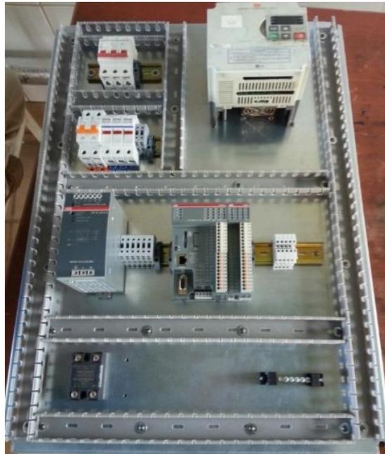
Instalación de los equipos dentro del tablero de control. (Pérez & Cofre)
