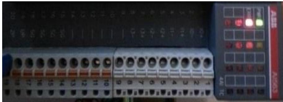
Módulo análogo AI563 utilizado para recibir las señales análogas de los sensores de temperatura de la máquina. (Pérez & Cofre)
