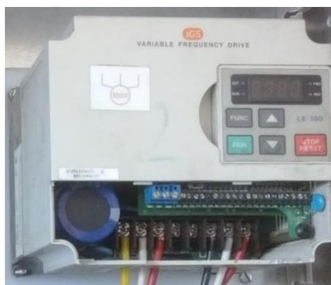
Variador de frecuencia LS SV037IG5-2 utilizado para el control de velocidad de la batidora de turrón. (Pérez & Cofre)
