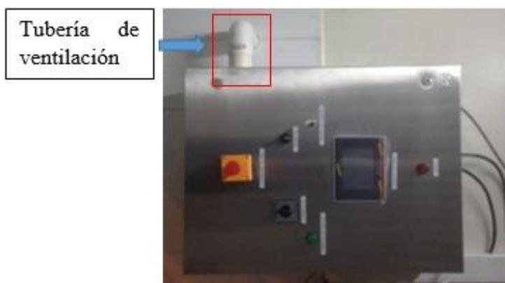
Tubería para el flujo de aire en el interior del tablero. (Pérez & Cofre)
