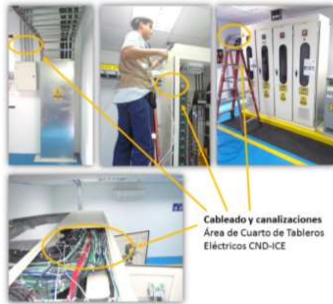
Figura 0.10 Cableado y canalizaciones para red de comunicación en Área de cuarto de tableros CNDICE
