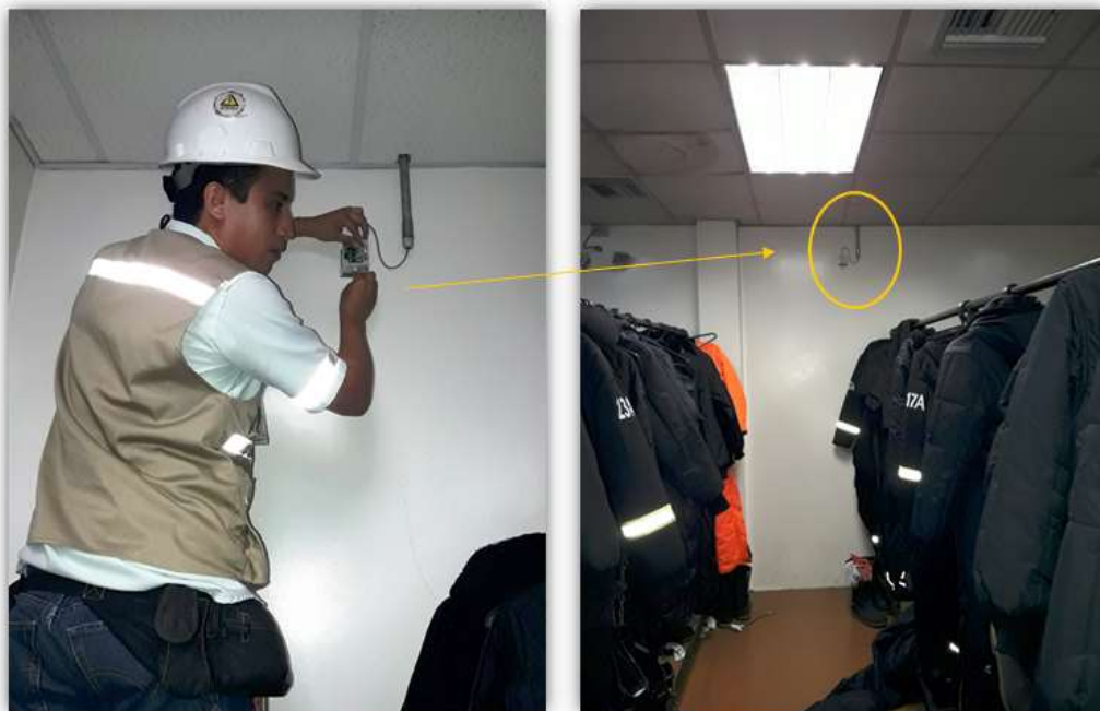
Figura 0.18 Montaje en pared de la sonda de temperatura THDGRS485.
