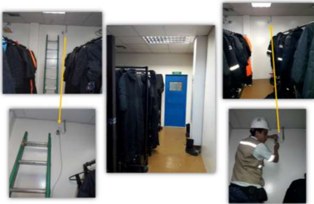
Figura A 5 Instalación de sonda de temperatura en cuarto de secado de chompas
