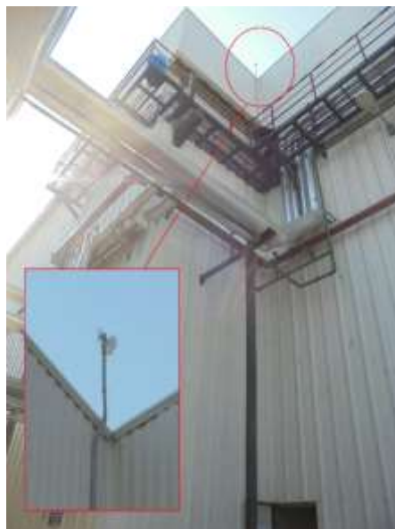
Figura 0.30 Montaje de antena emisora Access Point AP
