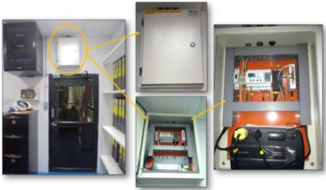
Figura 0.8 Montaje de tablero de Monitoreo en Área Subest. Eléctrica y Sala de Máquinas
