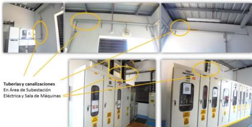
Figura 0.11 Cableado y canalizaciones para red de comunicación en Área de Subest. Eléctrica y Sala de Máquinas
