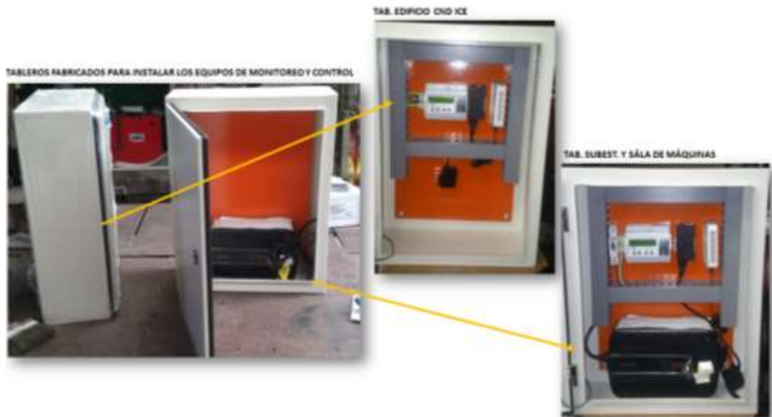
Figura 0.6 Montaje de equipos de monitoreo y control en tableros
