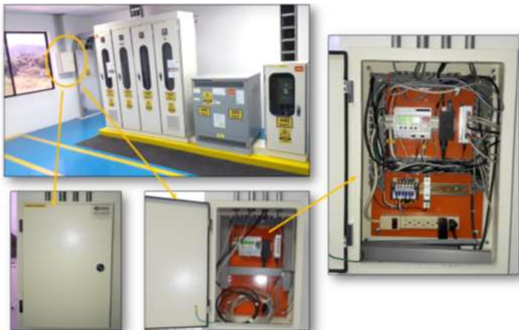
Figura 0.7 Montaje de Tablero de Monitoreo en Área de edificio CND-ICE.
