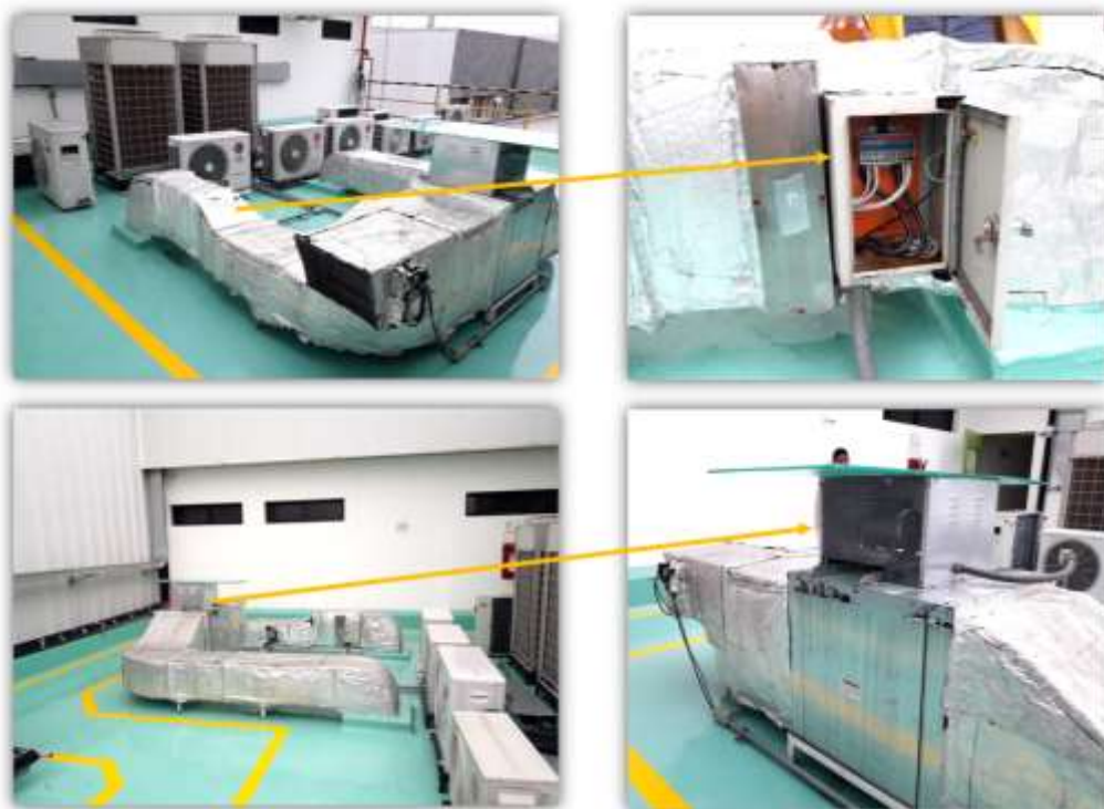
Figura A 3 Sistema de recirculación de aire forzado para cuarto de secado de chompas
