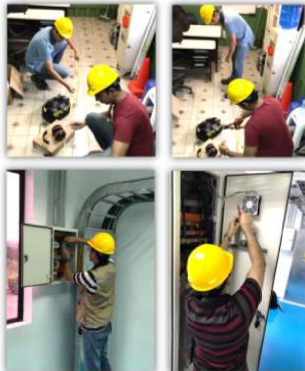
Figura A 2 Conexión de equipos de monitoreo y control
