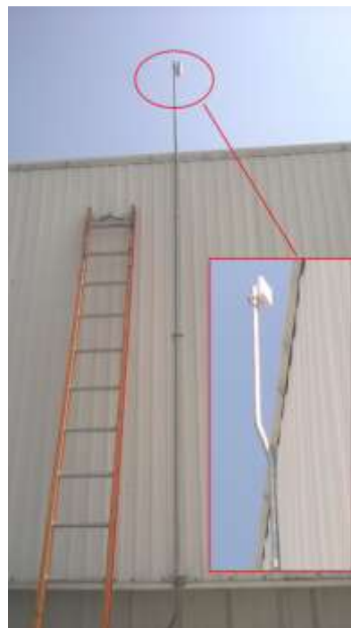
Figura 0.32 Montaje de antena receptora (Estación)
