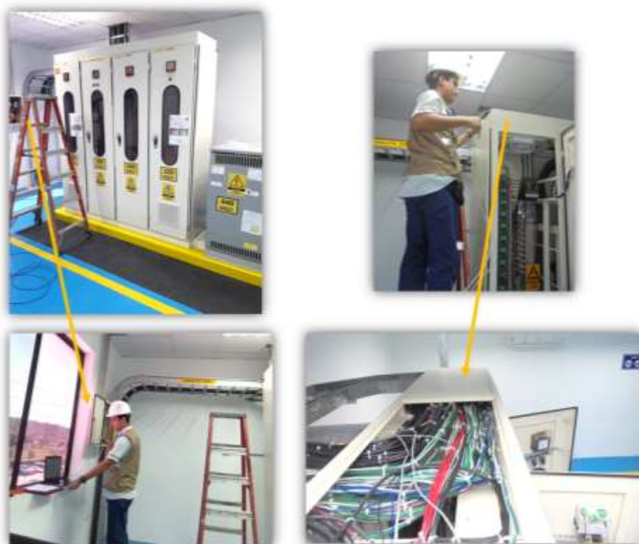
Figura A 4 Cableado de analizadores de redes en cuarto eléctrico de Área CND-ICE
