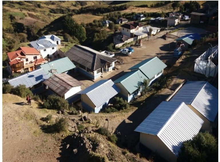
INFRA ESTRUCTURA DEL CECIB "AMI"
