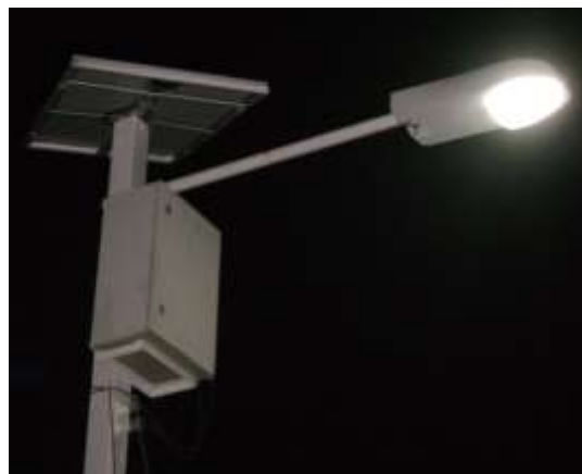
Figura 4. 15. Luminaria Solar ESCO-TEL operando en la noche. ( Esco-tel, 2017 )
