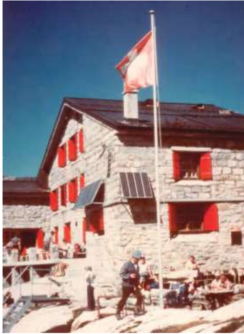
Figura 1. 1. Los 400 Wp generadores solares en el Monte Rosa Hostel a finales de 1980. Tales albergues hoy comúnmente tienen instalaciones fotovoltaicas con un mínimo de 3 kWp de potencia (Foto: Fabrimex / Willi Maag). (Haberlin, 2012)
