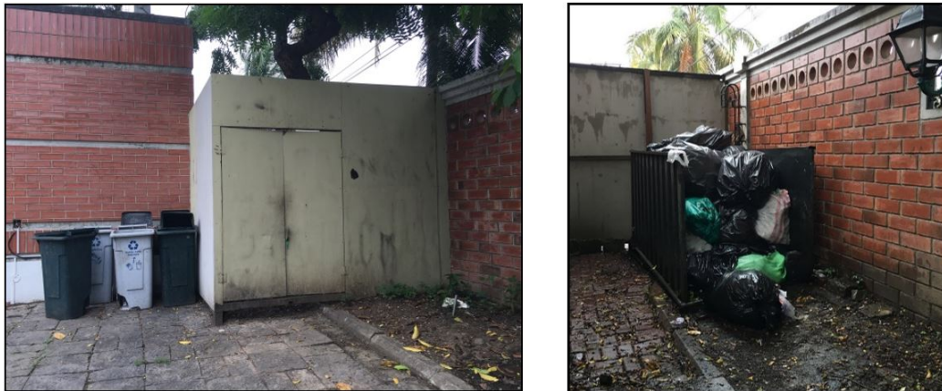
Figura 7. Área de almacenamiento de desechos no peligrosos (a) Centro de Acopio; (b) Contenedor en el Centro de Acopio
