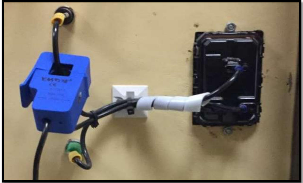
FIGURA 25: COLOCACIÓN DE SENSOR DE CORRIENTE EN TOMACORRIENTE.
