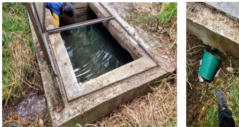
Figura 15. Caja recolectora y aforo de la vertiente Cotama Pogyo Elaborado por: David Rosado.
