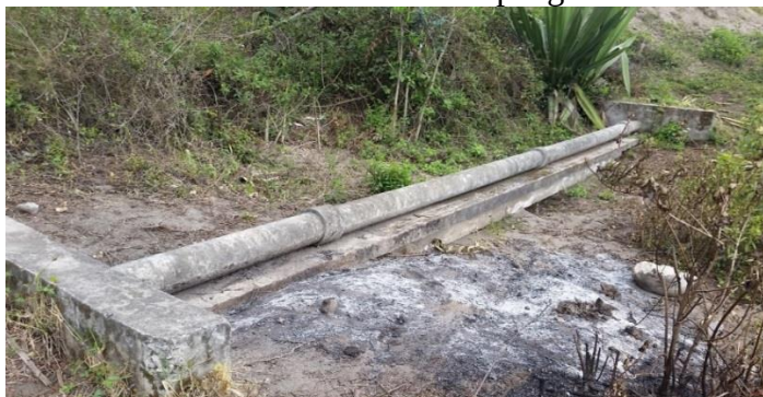
Figura 12. Paso elevado en la conducción Apangora. Elaborado por: David Rosado.
