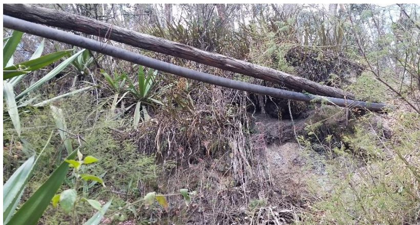
Figura 22. Paso elevado de conducción. Elaborado por: David Rosado.
