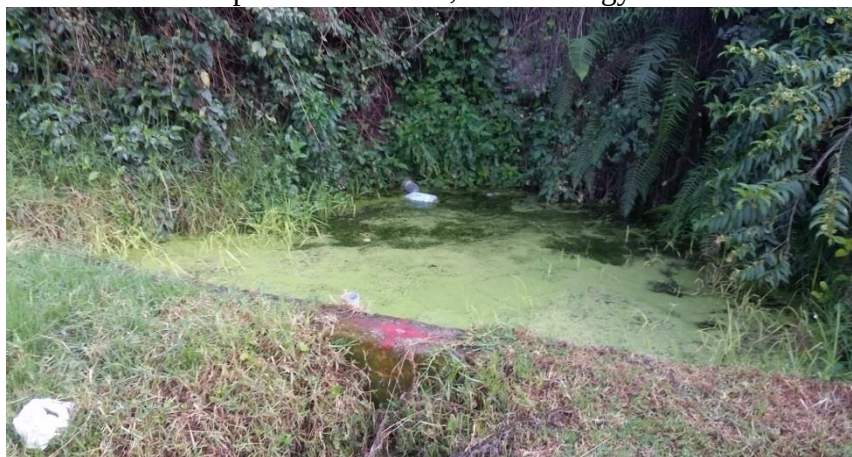
Figura 26. Estructura de captación existente, Mesías-Pogyo.
