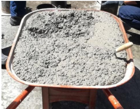
Figura 2. Mezcla fresca del hormigón convencional
