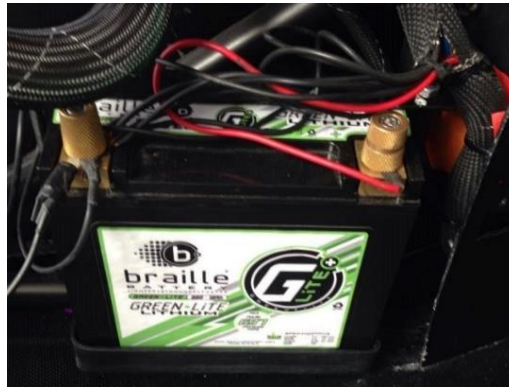
Figura 30 Montaje de la batería. [5]
