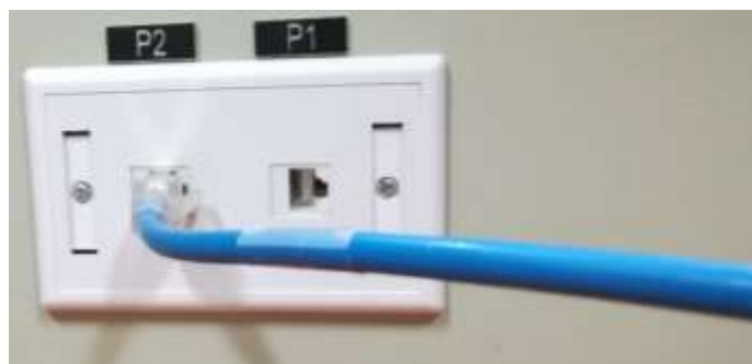
Figura 37. Habilitación del puerto P2.
