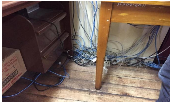
Figura 16. Cableado en canaletas Elaborado por: Marcos Naranjo y Alejandro Silva.
