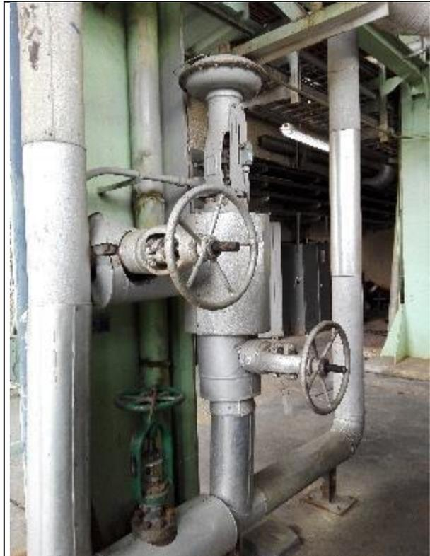
Figura 2.11. Línea de recirculación o flujo mínimo
