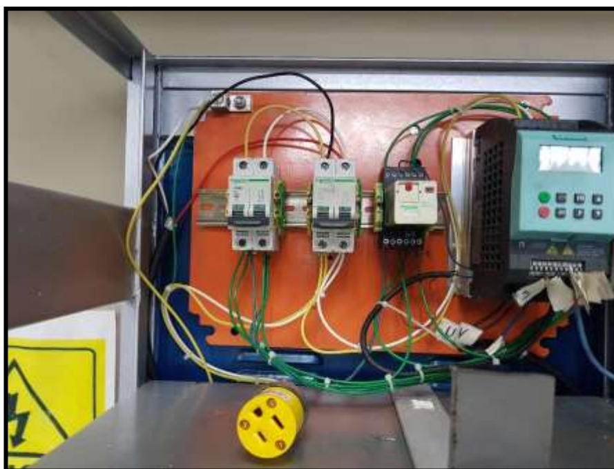
Figura 33: Construcción tercera parte del proyecto.
