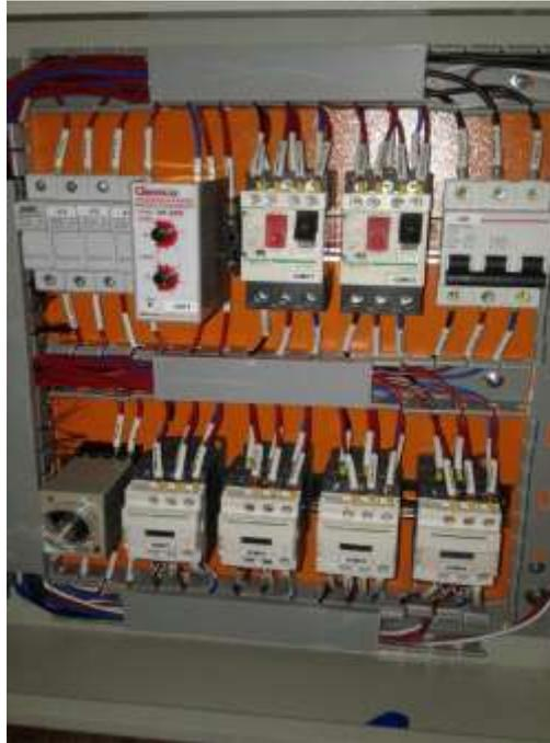
**Figura 37:** Montaje de los elementos de fuerza en una de las caras internas del módulo.
