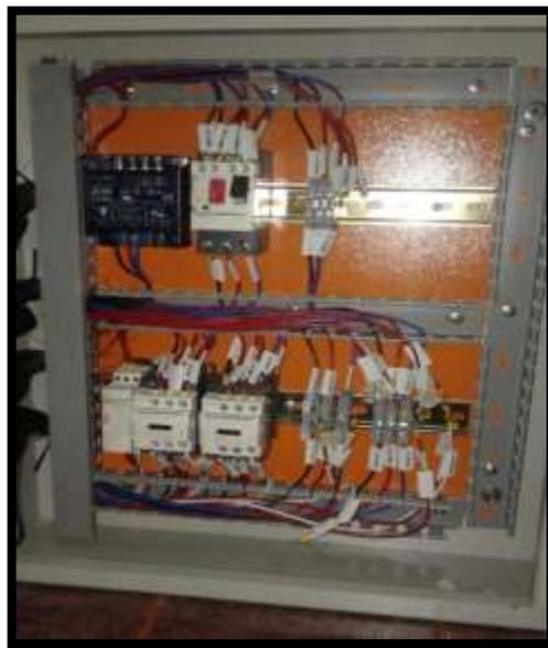
**Figura 77:** Cableado de equipos de fuerza.
