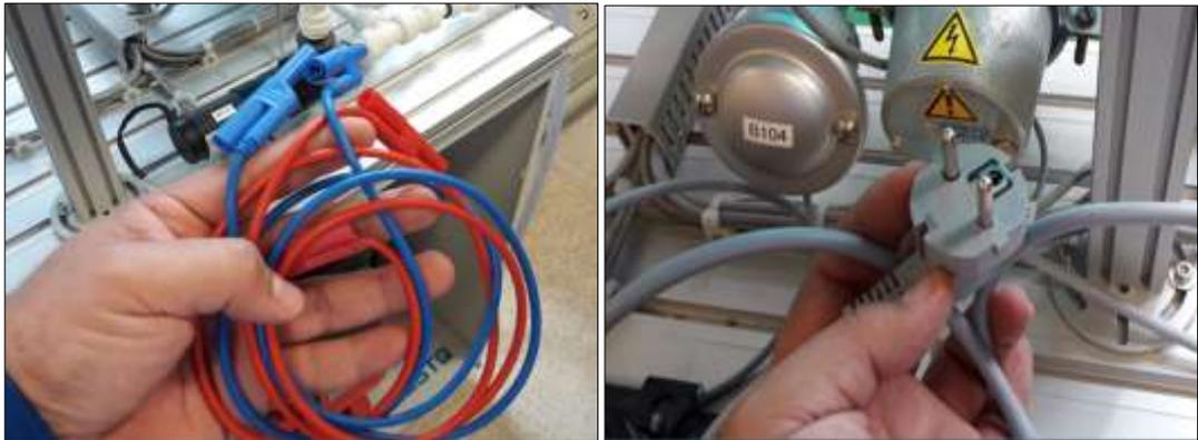
**Figura 407.** Cables de terminal de banana de alimentación al PLC (izquierda) y Cable de alimentación del Calefactor (derecha).
