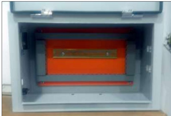
**Figura 53.** Panel con canaletas y riel instalados.
