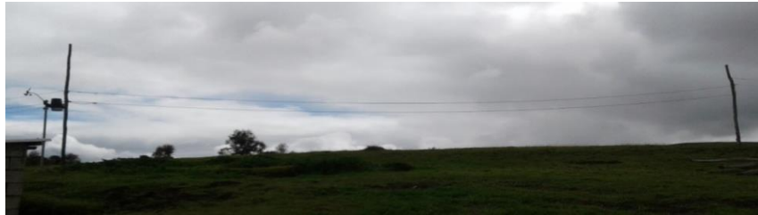
Figura 2. 10 Infraestructura de tendido eléctrico predominante en la zona Elaborado por: Tania Aguirre y Rodrigo Suárez
