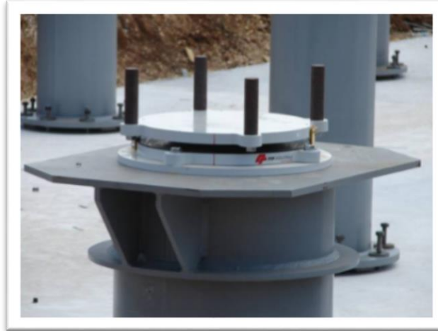
Figura 7. Aisladores de péndulo
