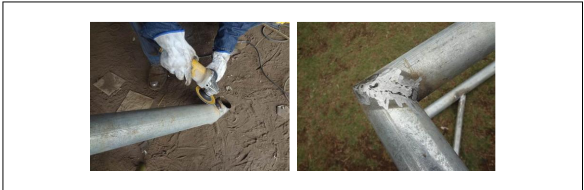
Figura N° 9. Esmerillado y resultado del esmerillado de la resbaladera
