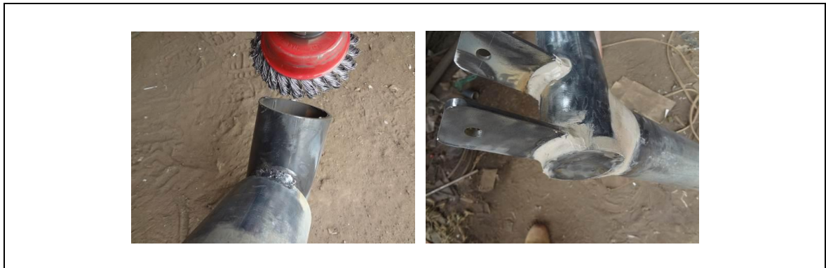
Figura N° 11. Pulido y masillado de la resbaladera
