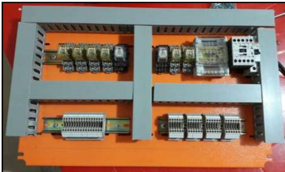
FIGURA 184: MONTAJE DE EQUIPOS EN PLAFÓN
