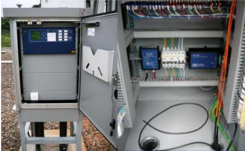
FIGURA 36: REEMPLAZO DEL CABLEADO DE COBRE CON FIBRA ÓPTICA – SUBESTACIÓN GUARUJÁ - BRASIL
