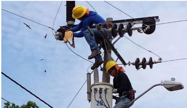
FIGURA 13 TÉCNICOS DE CNEL EP UNIDAD DE NEGOCIO SANTO DOMINGO, REALIZARON EL MANTENIMIENTO DE 15 TRANSFORMADORES Y LA LIMPIEZA DE AISLADORES EN TODA EL ÁREA DE SERVICIO QUE COMPRENDE EL MATAI, EN EL CANTÓN JAMA, PROVINCIA DE MANABÍ [10].
