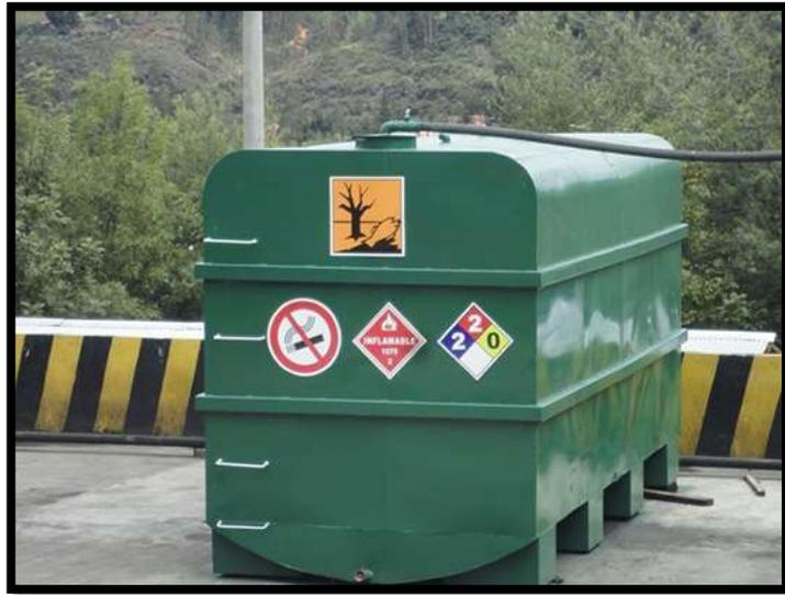
Figura 3.5. Tanque auxiliar de almacenamiento. Fuente. (ETAPA EP, 2016)
