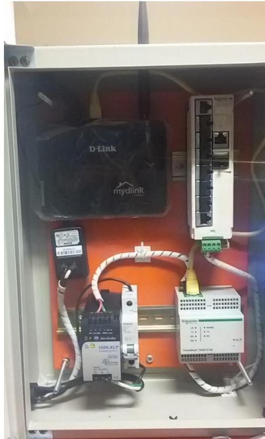
*Figura 27. Conexión de equipos de módulo Modbus TCP (Autores, 2016)*
