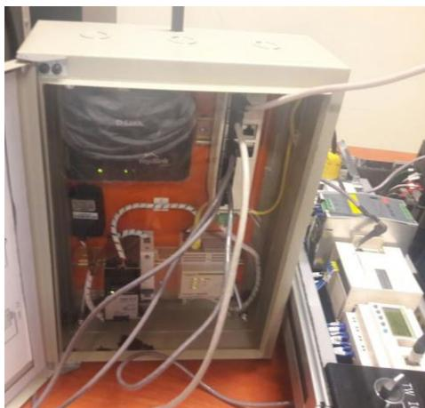
**Figura 30. Conexión de los dispositivos esclavos en el HUB Modbus (Autores, 2017)**
