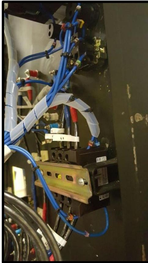
FIGURA 49: MÓDULO DE DISTRIBUCIÓN. ROTULADO E IDENTIFICACIÓN CON COLORES PARA CIRCUITO DE FUERZA, COLOCACIÓN DE MARQUILLAS PARA CIRCUITO DE CONTROL. FUENTE: LOS AUTORES.
