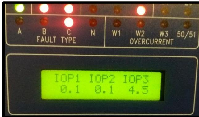
FIGURA 148: CORRIENTE DE OPERACIÓN EN LA FASE C DEL ALIMENTADOR DE -T5 PRODUCIDA POR MALA CONEXIÓN DE LOS TC, EQUIVALENTE AL DOBLE DE IRT3. FUENTE: LOS AUTORES.
