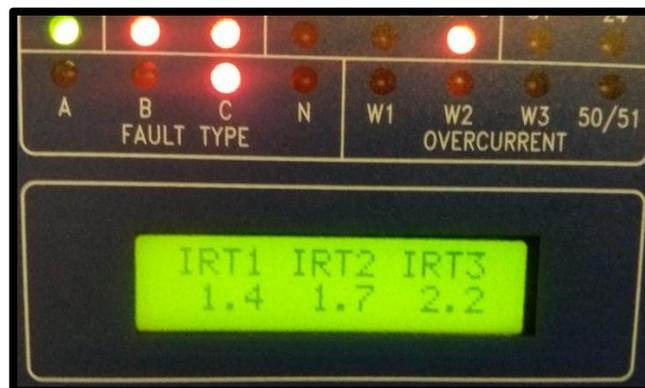
FIGURA 149: CORRIENTE DE RESTRICCIÓN DEL ALIMENTADOR DE -T5. FUENTE: LOS AUTORES.
