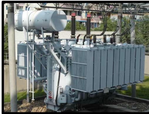
FIGURA 59: TRANSFORMADOR DE POTENCIA 5 MVA. FUENTE: [21].
