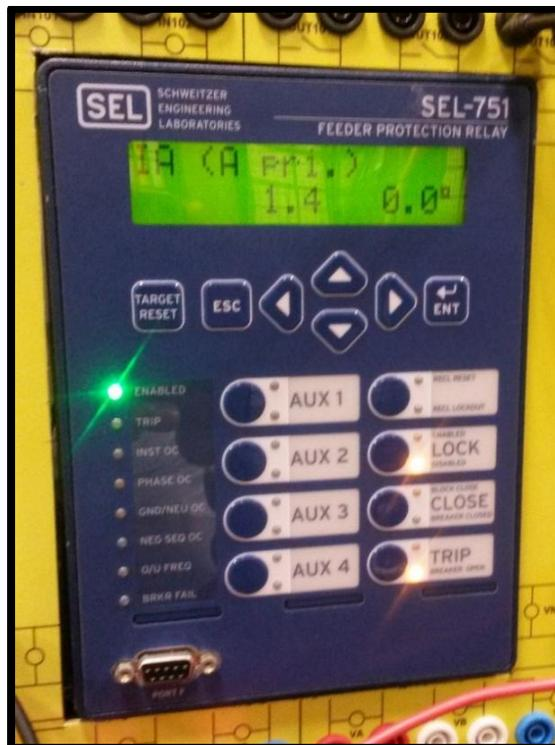
FIGURA 52: MÓDULO DE DISTRIBUCIÓN. MEDICIÓN DE CORRIENTE EN LA FASE A DEL ALIMENTADOR DE -T5 POR MEDIO DEL RELÉ SEL-751 A. FUENTE: LOS AUTORES.
