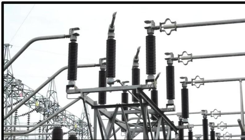
FIGURA 16: SECCIONADOR DE SUBESTACIÓN. FUENTE: [15].
