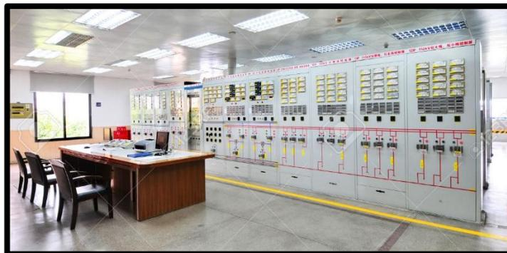
FIGURA 15: SALA DE CONTROL DE UNA SUBESTACIÓN, EQUIPOS DE MEDICIÓN, INDICADORES, SELECTORES, RELÉS DE PROTECCIÓN. FUENTE: [14].
