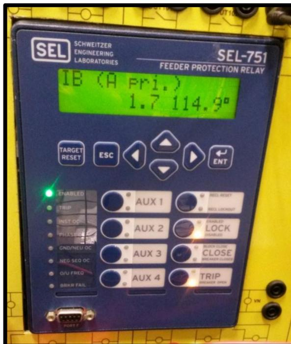
FIGURA 54: MÓDULO DE DISTRIBUCIÓN. MEDICIÓN DE CORRIENTE EN LA FASE B DEL ALIMENTADOR DE -T5 POR MEDIO DEL RELÉ SEL-751 A. FUENTE: LOS AUTORES.
