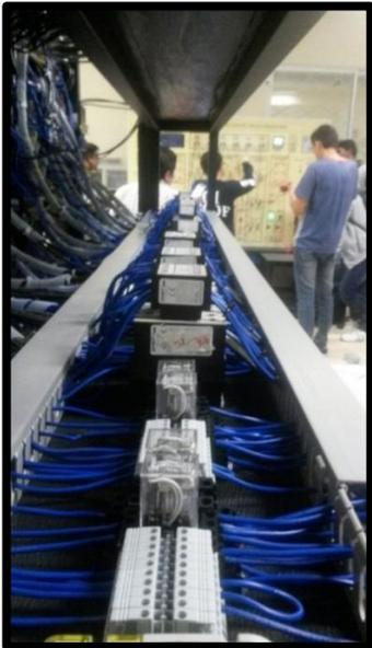
FIGURA 46: MÓDULO DE DISTRIBUCIÓN. COLOCACIÓN DE TAPA PLÁSTICA PARA CANALETA PORTACABLES. FUENTE: LOS AUTORES.
