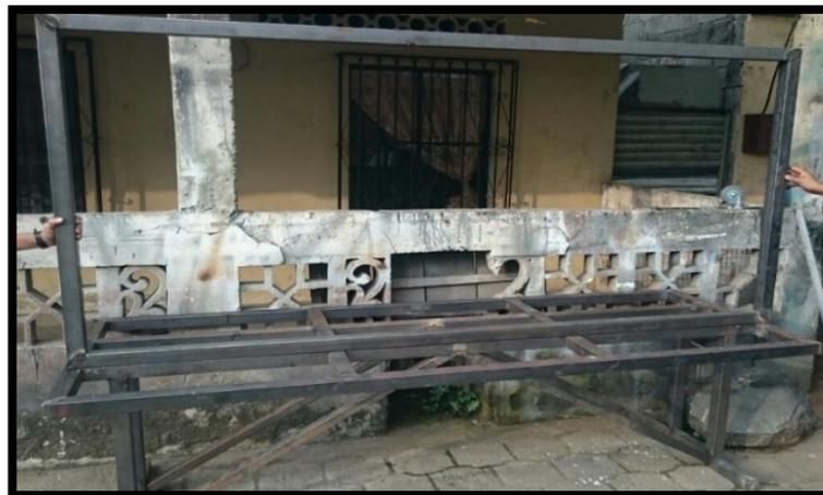
FIGURA 31: MÓDULO DE DISTRIBUCIÓN. CONSTRUCCIÓN DE LA ESTRUCTURA METALMECÁNICA DEL TABLERO. FUENTE: LOS AUTORES.
