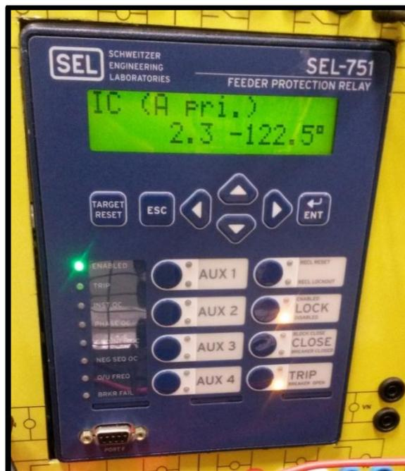
FIGURA 56: MÓDULO DE DISTRIBUCIÓN. MEDICIÓN DE CORRIENTE EN LA FASE C DEL ALIMENTADOR DE -T5 POR MEDIO DEL RELÉ SEL-751 A. FUENTE: LOS AUTORES.
