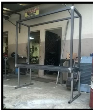
Figura 19: Construcción de la Estructura
