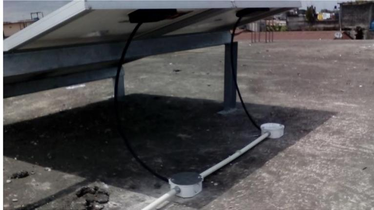
**Figura 34:** Conexión en paralelo de los módulos fotovoltaicos
