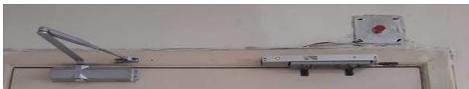
Figura 4.25 Actuador magnético, brazo hidráulico y botón de emergencia
