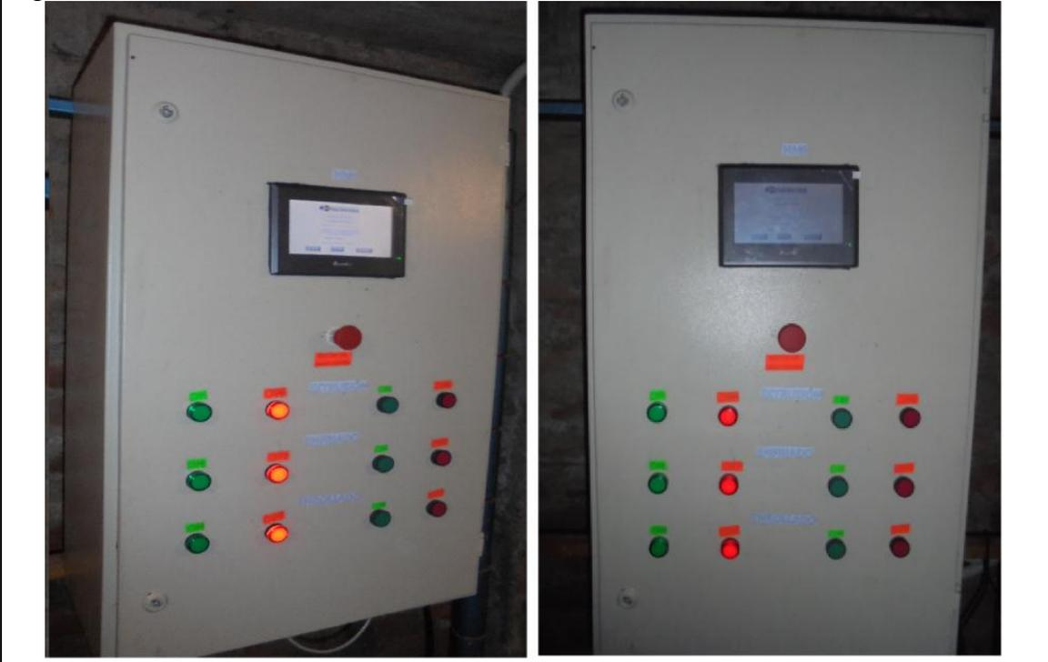
A través del HMI se podrá revisar los gráficos que despliega la temperatura del extrusor así como las botoneras de cada etapa y un panel de alarmas desplegadas que se explicará de mejor manera en el ítem 4.1.9.
